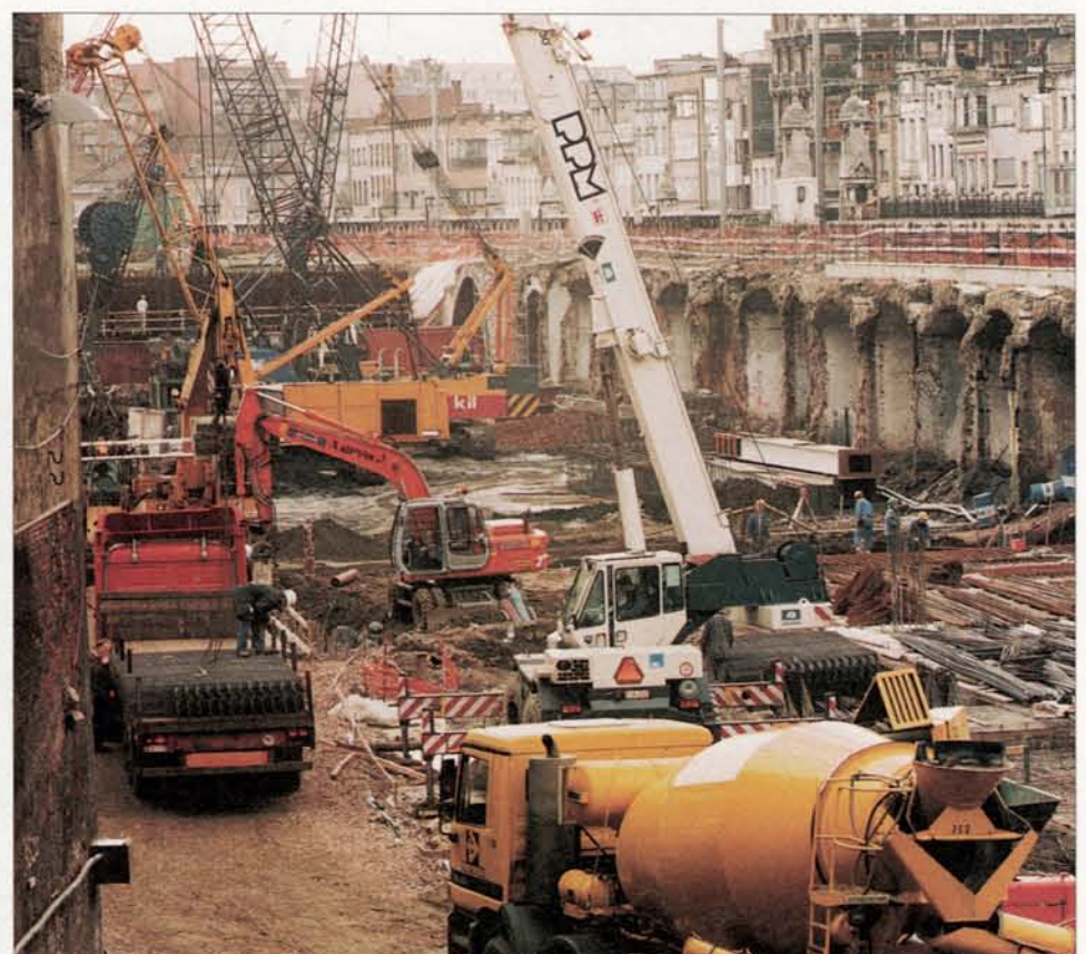
Er wordt volop gewerkt aan de steunkolommen waarop in de lente van volgend jaar de treinen Antwerpen-Centraal zullen binnenrijden.
