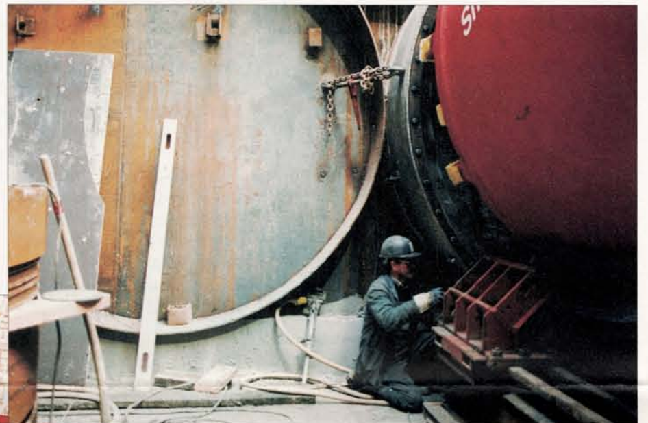
'De Mol' wordt klaargemaakt voor het persen van één van de acht buizen onder Antwerpen-Centraal.
