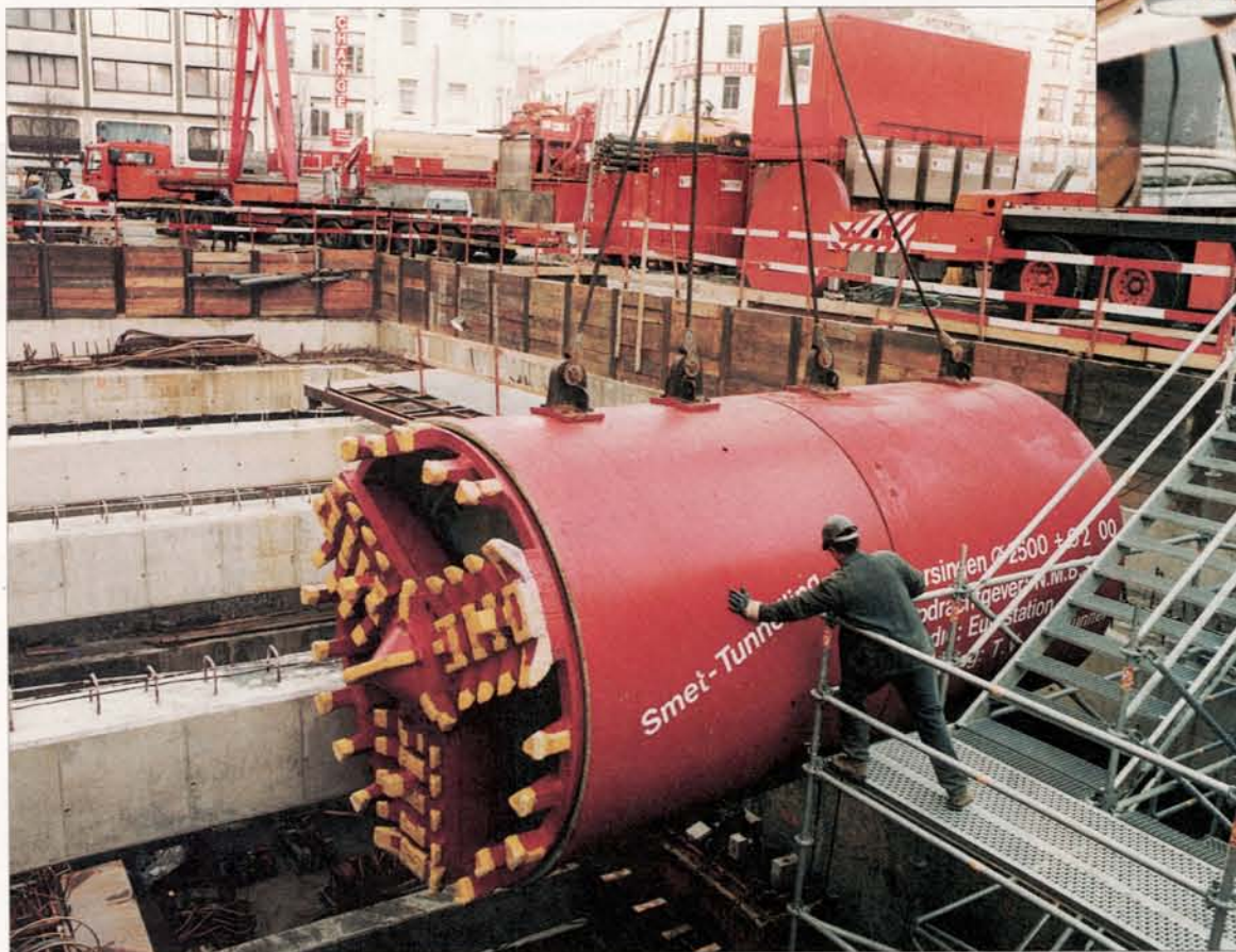
Het 64 ton wegend boorschild werd met een speciale kraan neergelaten in de bouwput op het Astridplein.
